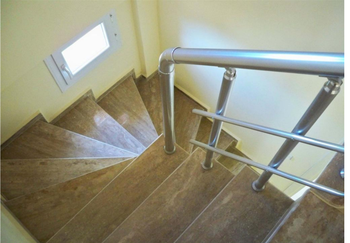
Çatı çatından alt kata iniş merdiveni
