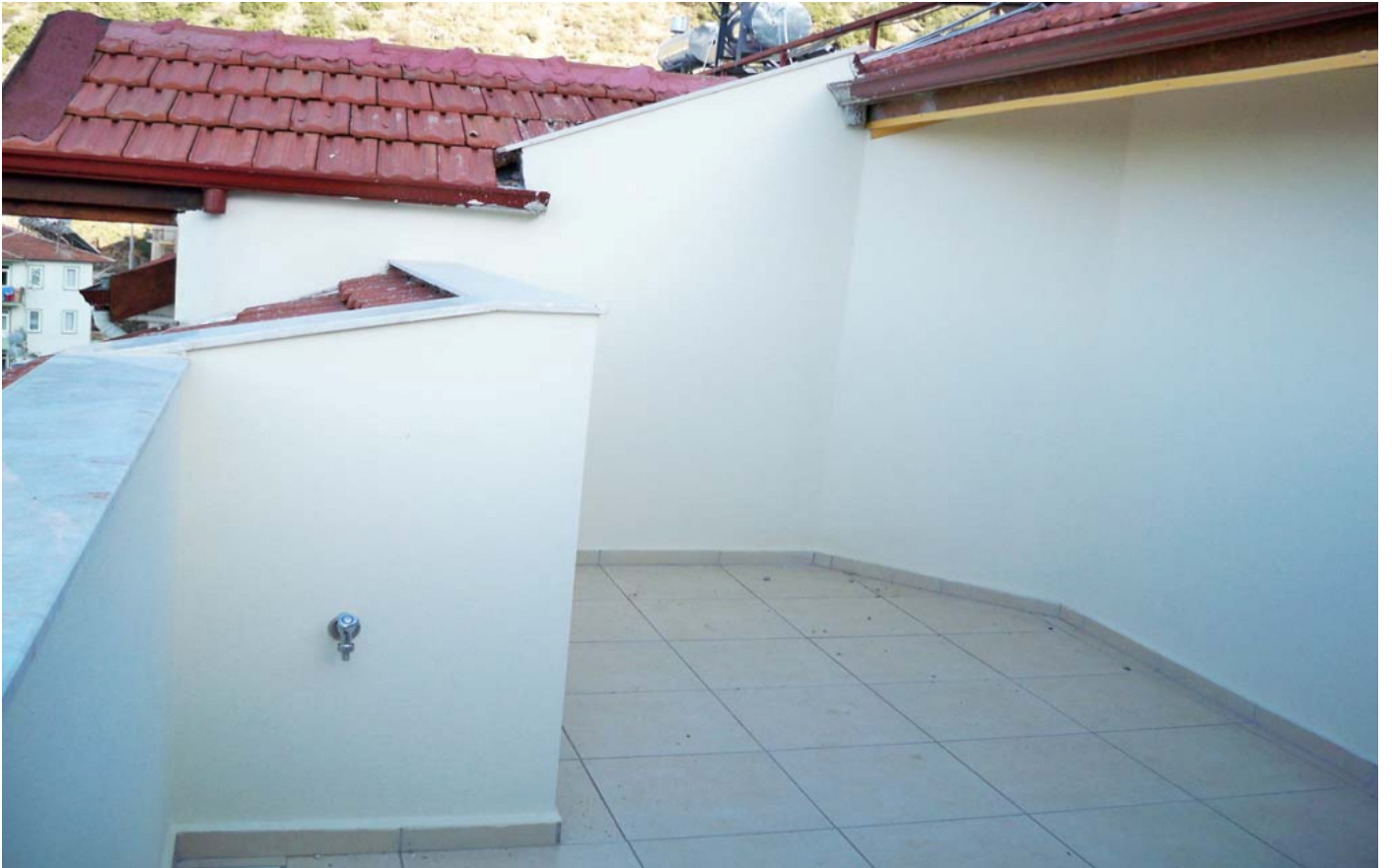
Çatı katının terası
