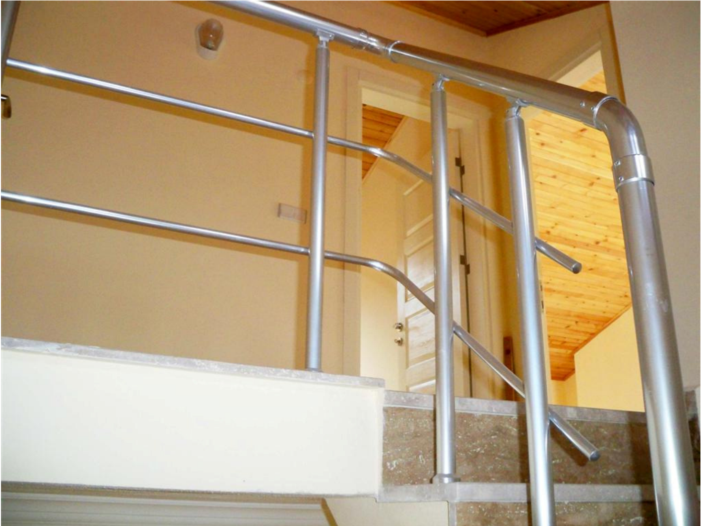
Çatı katının genel görünüşü
